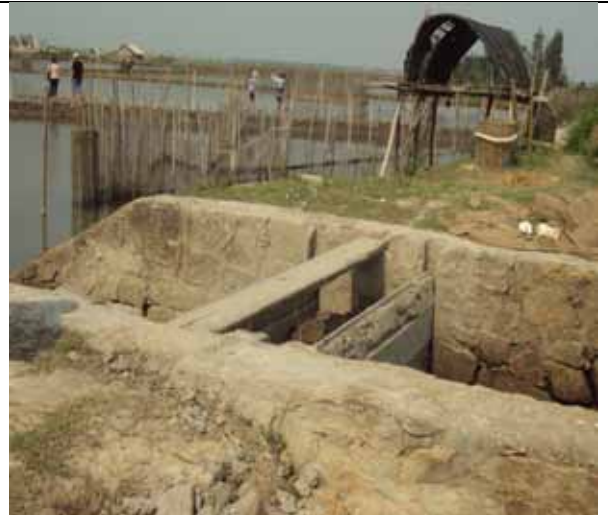
Hệ thống các ống cống thông Rú Chá với phá Tam Giang
